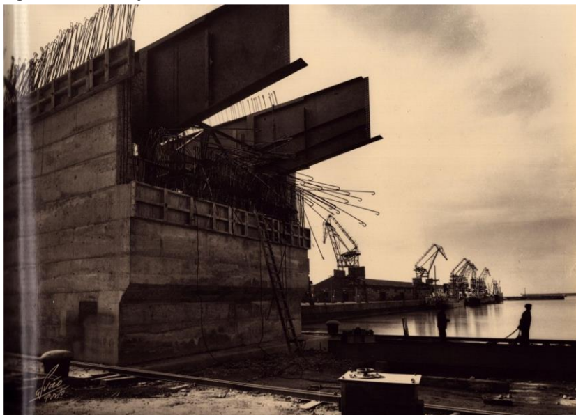
Figura 12. Construção da Ponte Móvel
