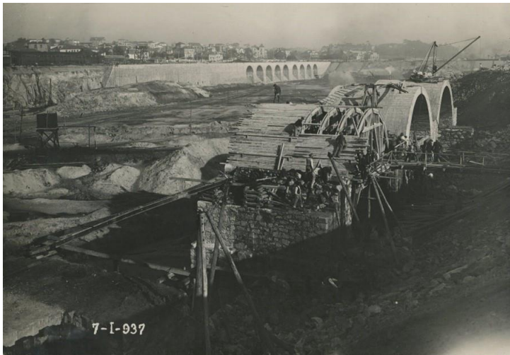
Figura 8. Construção da Doca n.º 1 (1930-1940)
