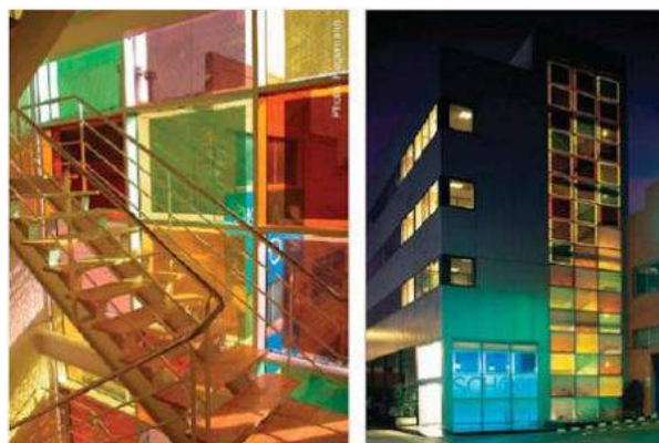
Figura 2 - Integração de painéis de TFPC (inorgânico) em edifícios, nomeadamente nas janelas - Edifício Schott Iberica , Barcelona [5]
