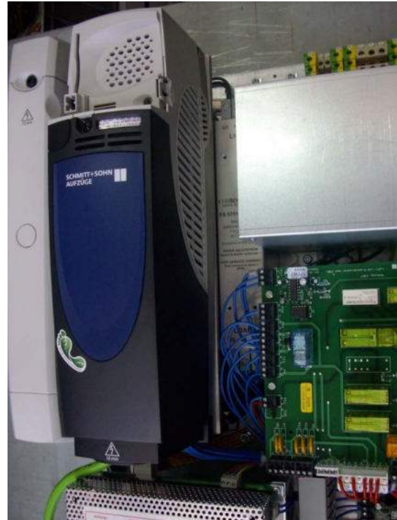
Figura 5 – Variador eletrónico de frequência (Fonte: Schmitt+Sohn Elevadores)
