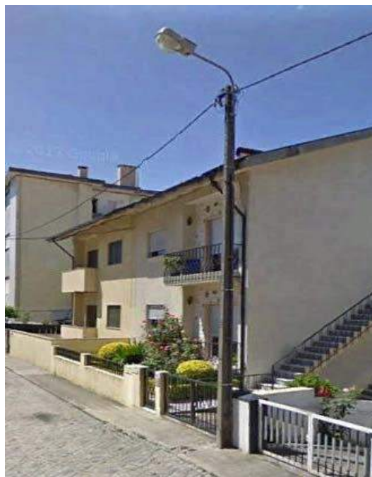
Figura 5. Tipo de poste existente
