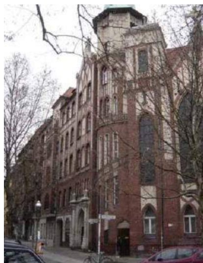
Fig. 1 – Vista do edifício em estudo
