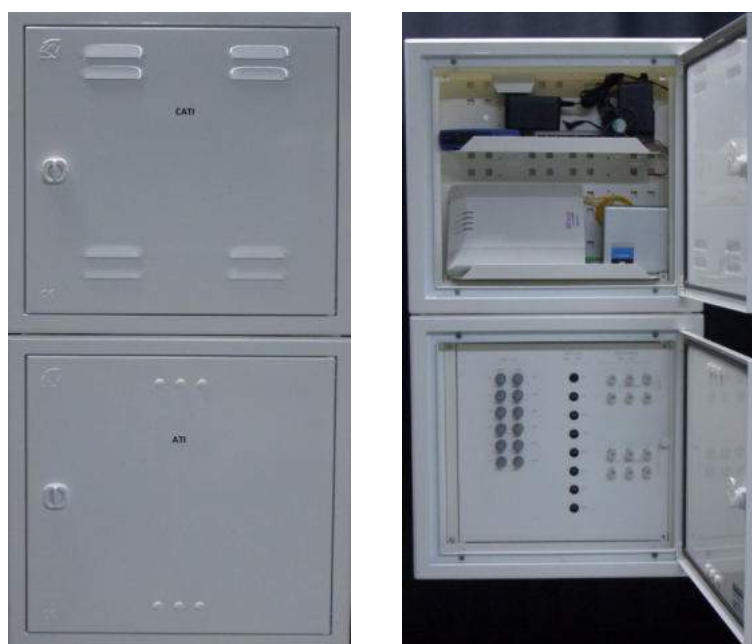
Figura 6 – Exemplo de uma possível solução ATI [Cortesia Quitérios]
