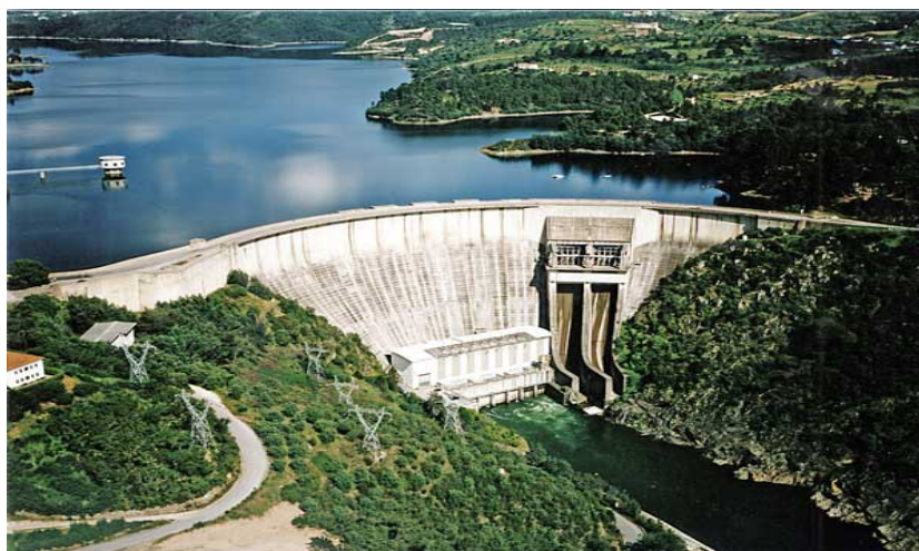
Figura 1. Aproveitamento hidroelétrico de Castelo de Bode no rio Zêzere (1951)
