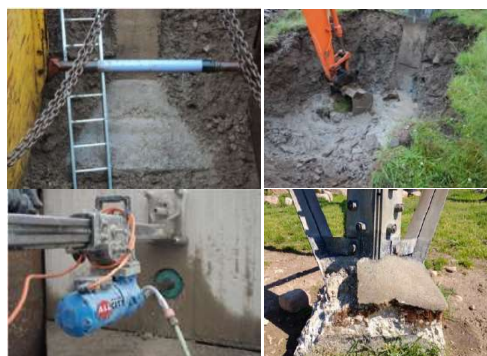
Figura 7. Recolha de provetes através de teste intrusivo
