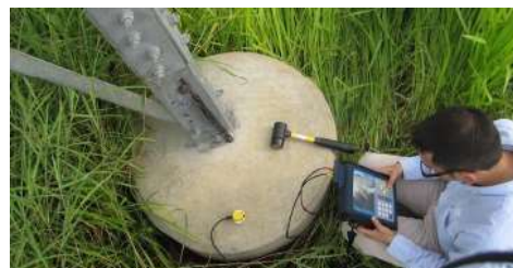
Figura 6. Avaliação da integridade da fundação com TD
