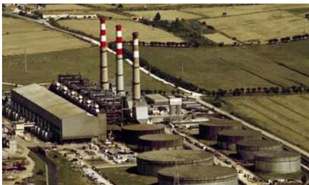
Figura 2 - Central Termoelétrica do Carregado
