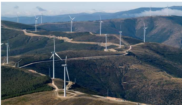
Figura 4 - Parque Eólico da Serra dos Candeeiros
