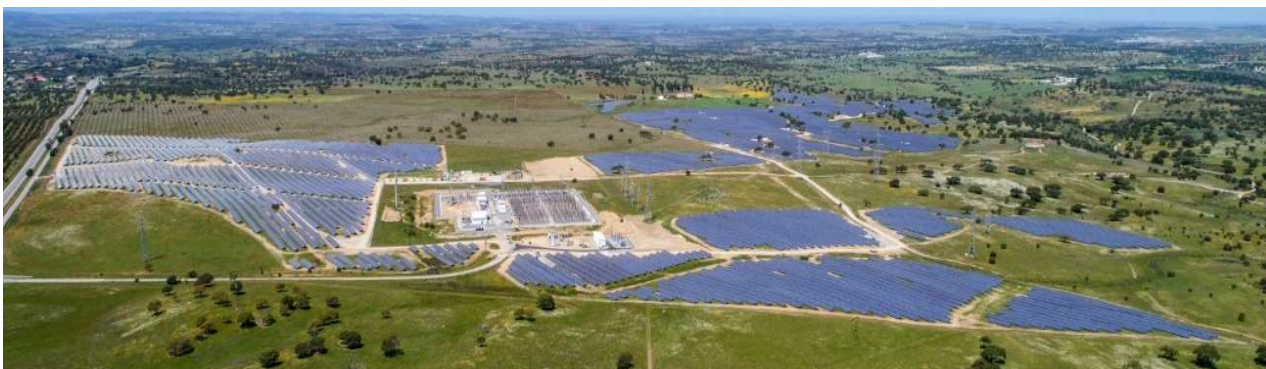
Figura 5 - Central fotovoltaica de Ourika 2
