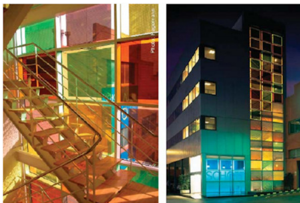
Figura 2 - Integração de painéis de TFPC (inorgânico) em edifícios, nomeadamente nas janelas - Edifício Schott Iberica , Barcelona [5]
