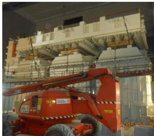
Figura 9: Transformador de potência 400kV em montagem
