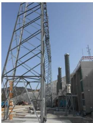
Figura 14: Pórtico de amarração da linha de 400kV
