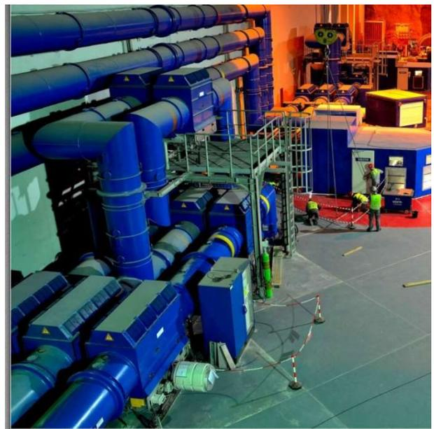
Figura 5: Barramento Isolado
