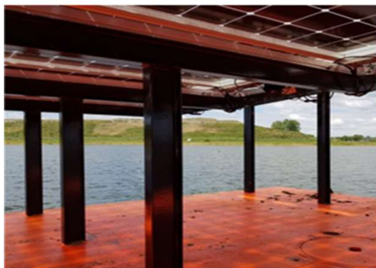
Figura 7 - Estrutura de base refletora em instalações flutuantes BPV [17]
