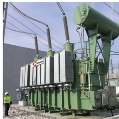
Figura 1. Transformador de Potência da RNT
