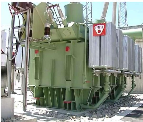
Figura 1 – Transformador de potência
