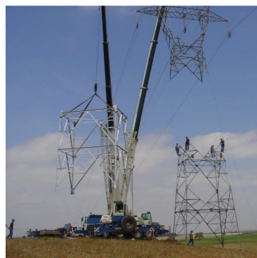
Figura 9. Colocação de módulo prismático com 6m em apoio existente
