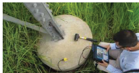
Figura 6. Avaliação da integridade da fundação com TD
