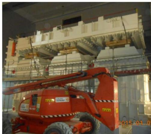
Figura 9: Transformador de potência 400kV em montagem
