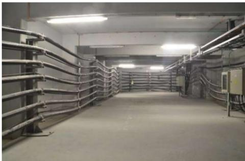
Figura 11: Cabo de 400kV instalado na base do edifício de comando 400kV
