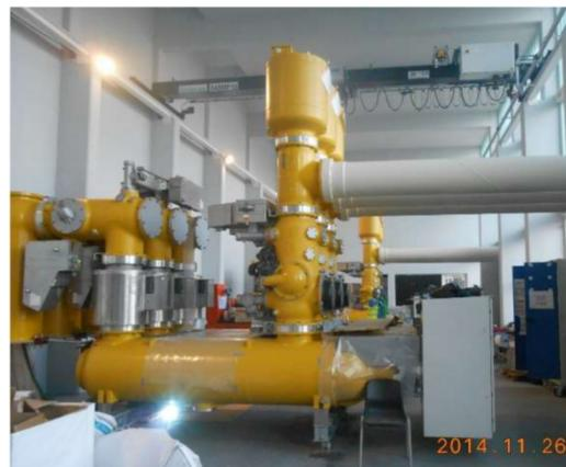
Figura 13: GIS de 400kV Siemens 8DQ1, 420kV 50kA
