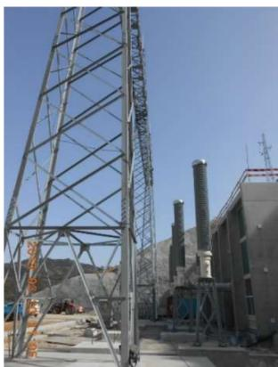
Figura 14: Pórtico de amarração da linha de 400kV
